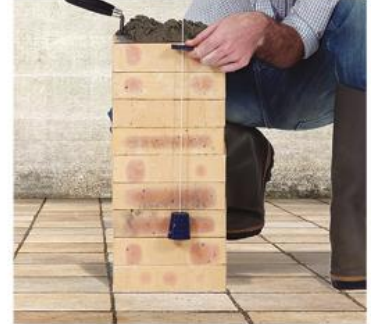
Hình ảnh dây dọi của thợ xây và nền nhà
