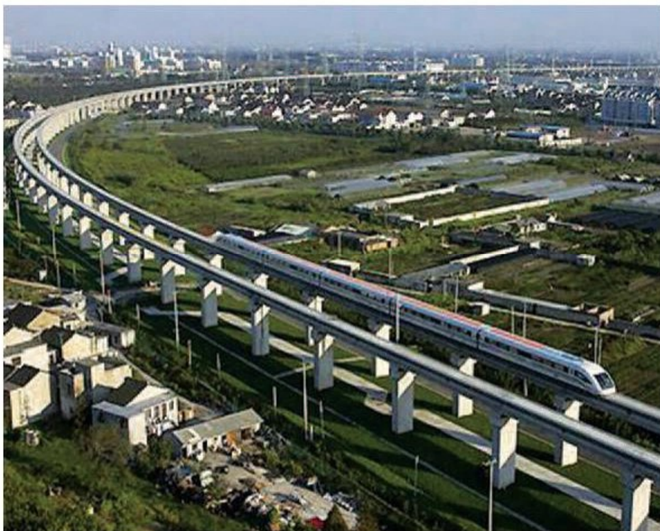
Hình 10.7. Tuyến đường sắt mới xây dựng ở Trung Quốc
